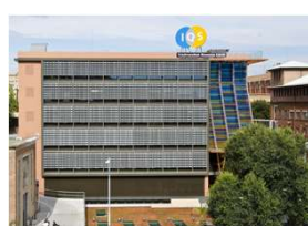
SOLERAS IQS SARRIÀ BARCELONA
