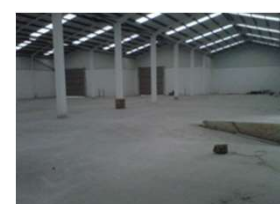
NAVE INDUSTRIAL GIPUZKOA
