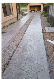
ACCESO IMPRESO GARAJE RUMANIA
