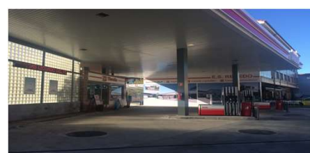
ESTACION SERVICIO CANTABRIA
