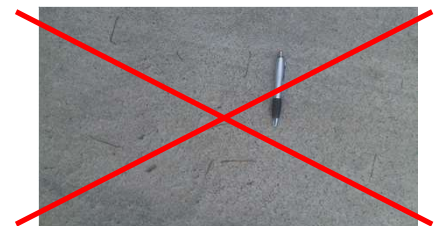
FIBRA ACERO, ESCASA, OXIDADA, SE DESPRENDE CON LA ABRASIÓN
