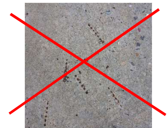
ACERO ESCASO, OXIDADO EN SUPERFICIE Y SE DESPRENDE
