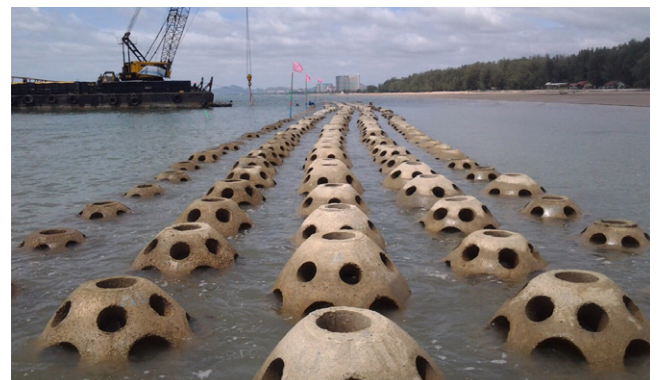
Barreras de domo de control de erosión: permitieron la eliminación de la cubierta de concreto, reduciendo el espesor de 150 mm a 50 mm.
