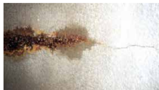
Imagen 1: El agrietamiento en el hormigón conduce a la penetración de materiales corrosivos, dando como resultado una rápida corrosión del refuerzo de acero.
